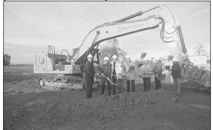
Beim symbolischen Spatenstich im Muckentaler Neubaugebiet „Brunnenfeld IV“ voll Elan dabei: (von links) Elztals Bauamtsleiter Christoph Tanecker, Steffen Leiblein, Bernd Stuck (beide IFK Ingenieure), Bürgermeister Marco Eckl, Ortsvorsteher Christoph Kuhnert, Sirko Große (Baufirma Wolff & Müller), und Georg Mohn (Mohn Ingenieure). Foto: Claus Kaiser
