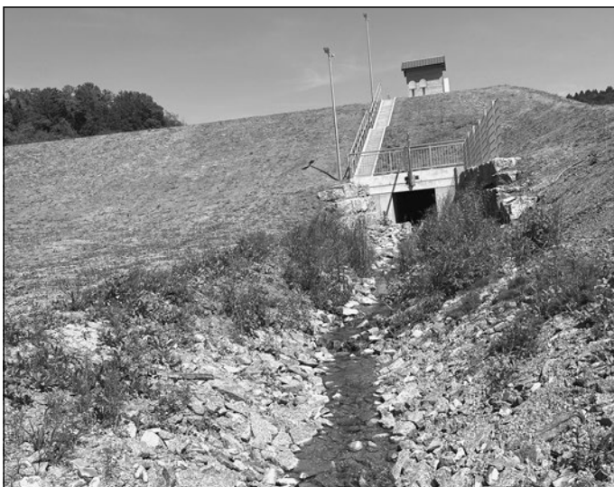
Schräg gegenüber des Dallauer Tierheimes wurde das imposante Hochwasserrückhaltebecken am Luttenbach errichtet.
