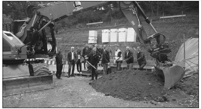
Symbolischer Spatenstich für den neuen Wasserhochbehälter Meertal in Dallau. 1,6 Millionen Euro werden in die Infrastruktur der Gemeinde Elztal investiert. Foto: Claus Kaiser
