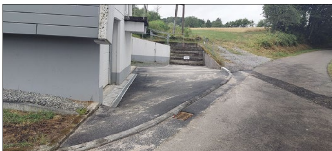
Das Bild zeigt den rückwärtigen Bereich.
