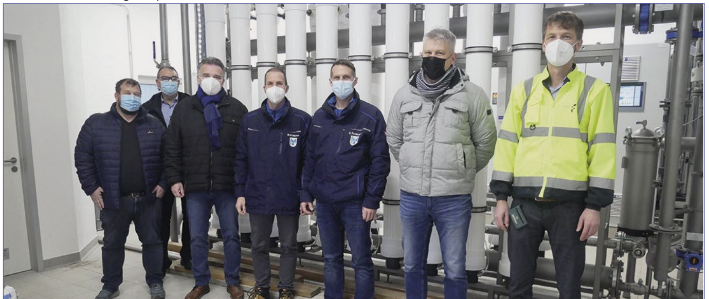
Bei der Inbetriebnahme der Ultrafiltrationsanlage im Dallauer Pumpwerk von links: Thiemo Gombert, Ralf Winkler, Marco Eckl, Ricko Fütterer, Christoph Tanecker, Arnd Koppelhuber und Florian Sylla. Foto: Claus Kaiser
