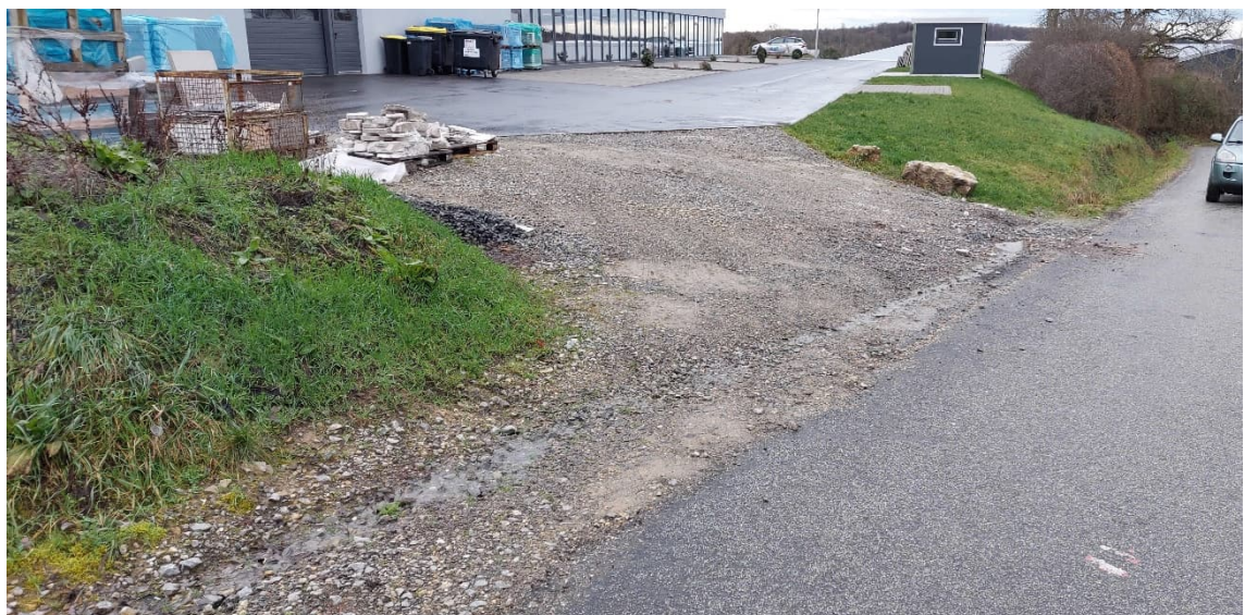
Abb. 2: Foto Bestandssituation (Quelle: Gemeinde Elztal)
