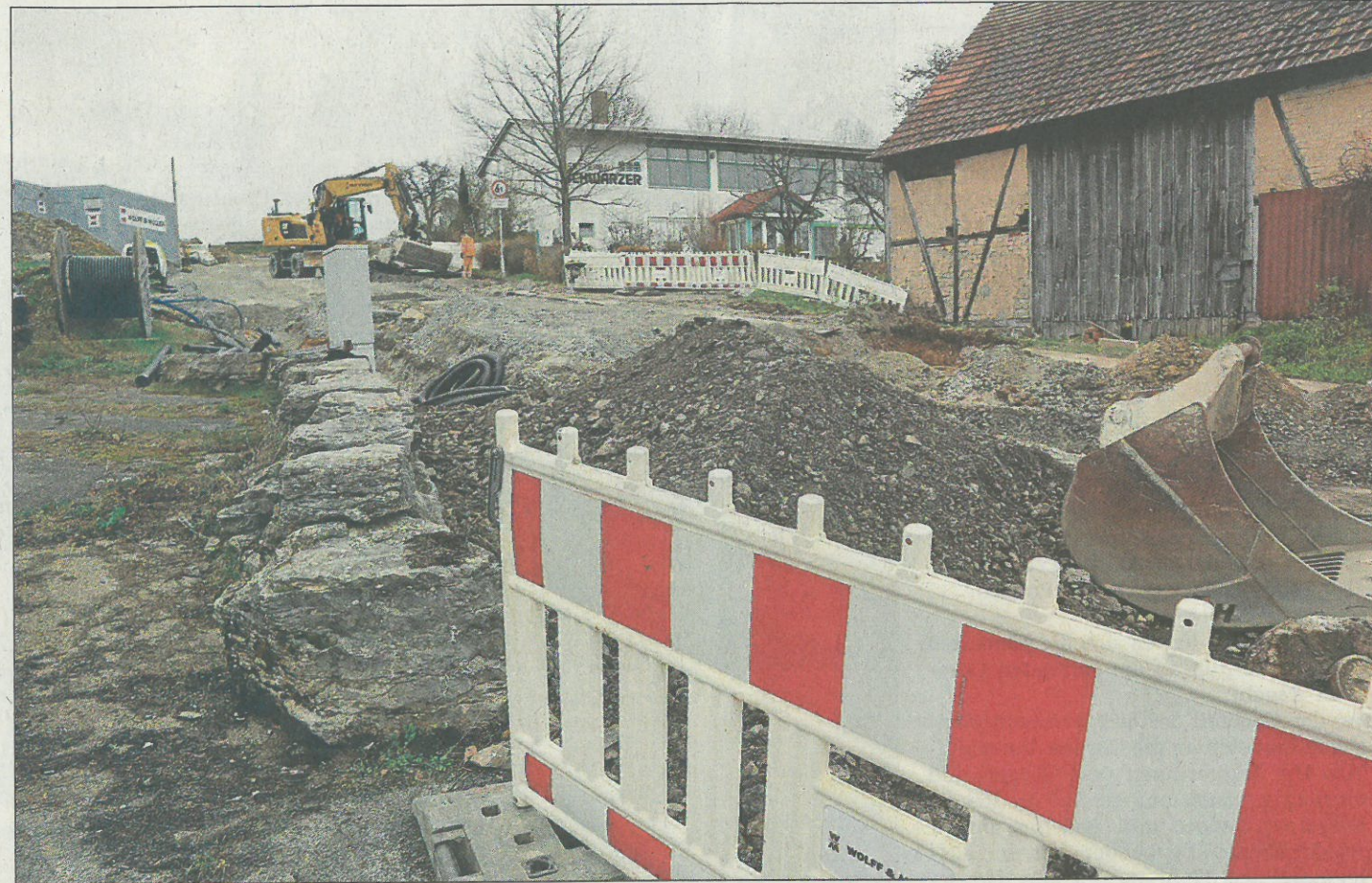
Für das neue Baugebiet „Oberer Wirbelbach“ werden zurzeit die Versorgungsleitungen gelegt. Zeitgleich läuft auch schon der Verkauf der 30 Bauplätze. Es gab 27 Bewerbungen, elf Plätze sind schon weg, sechs bereits zugewiesen. Foto: Karl Wilhelm Beichert
